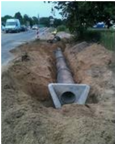
Fot. 7. Przepust z zamontowanym elementem wylotu
